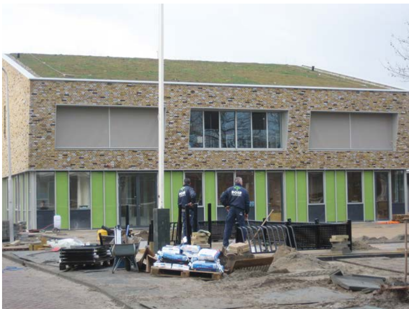
FIGUUR 1.2b Het eco-dak op een nieuw schoolgebouw
