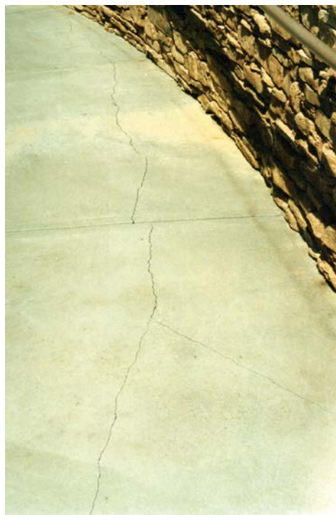
FIGUUR 1.6 Droogscheur in beton (oppervlaktесheur in voetpad, met stortnaad)
