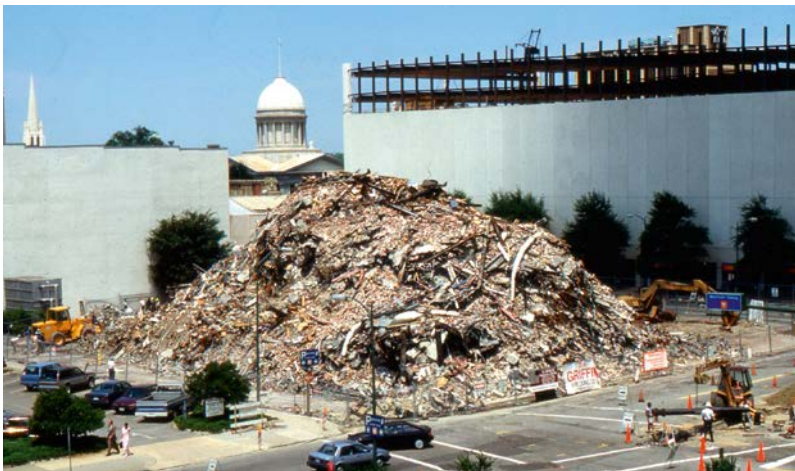
FIGUUR 1.10 Sloopafval via implosie
