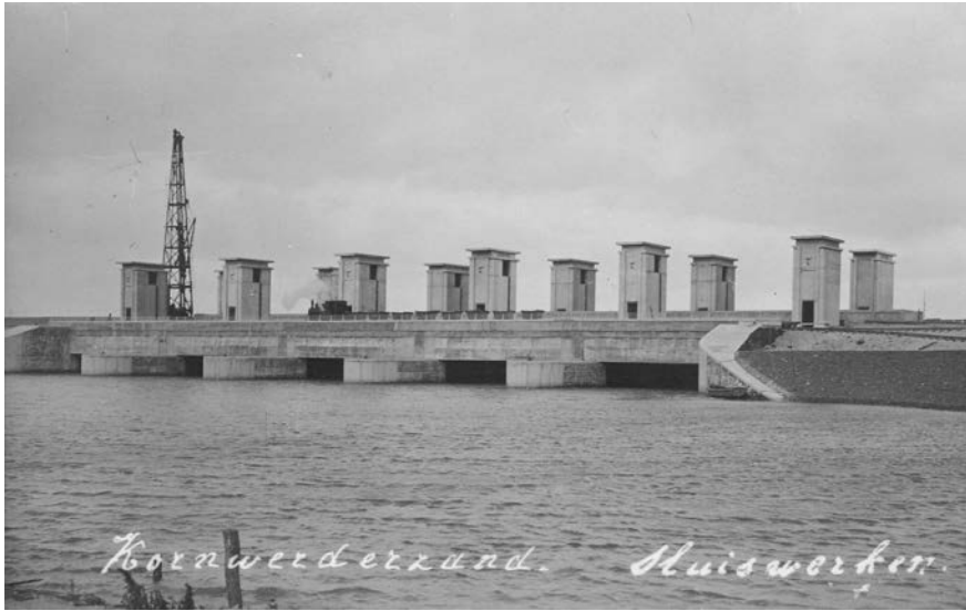
De spuisluizen op het Kornwerderzand tijdens het afwerken.
